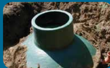
Prolongation de radier pendant l'installation
