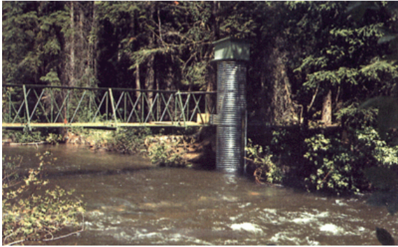
Figure 12. Puits de mesure en métal du type exposé installé près de la rive
