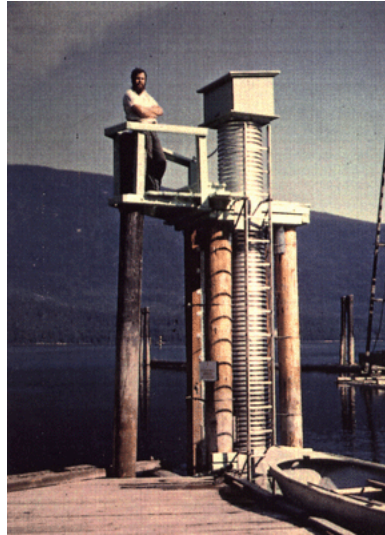
Figure 13. Puits de mesure en métal du type exposé installé au centre du cours d'eau
