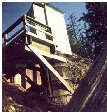
Figure 16. Puits de mesure en douves de bois installé sur la rive
