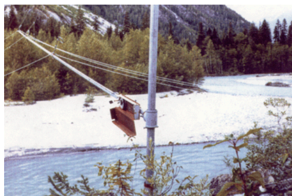
Figure 17. Dispositif de fixation d'un limnimètre à fil lesté installé sur une flèche
