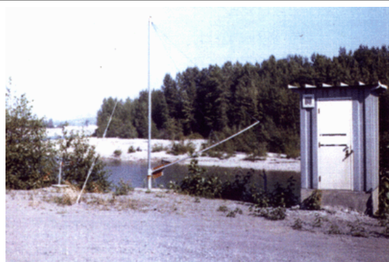
Figure 15. Vue arrière d'un limnimètre à flèche
