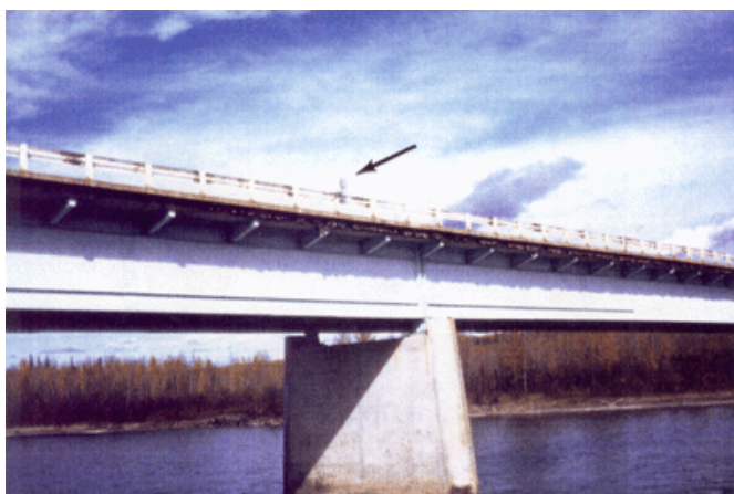
Figure 7. Limnimètre à fil lesté installé sur le garde-fou d'un pont (rivière Athabasca près de Windfall)
