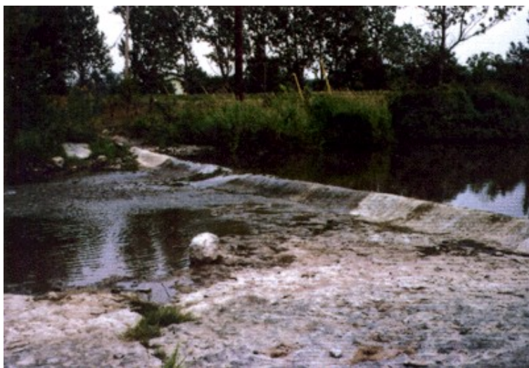
Figure 9. Ouvrage de contrôle à forme libre en béton, près d'Ottawa (Ontario)
