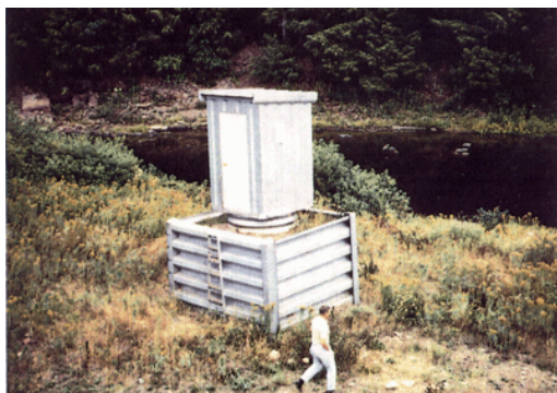
Figure 15. Puits de mesure en métal installé sur la rive
