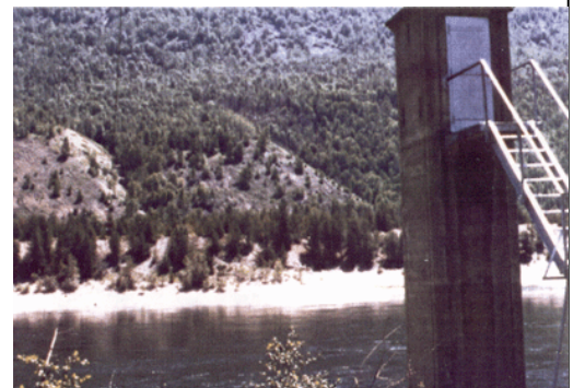
Figure 14. Puits de mesure en béton installé sur la rive
