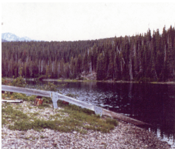
Figure 5. Échelle limnimétrique inclinée installée sur une poutre-H
