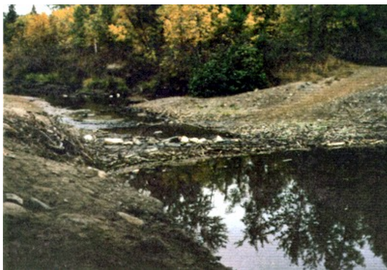
Figure 11. Ouvrage de contrôle à gabions, près de Val-Caron, (Ontario)
