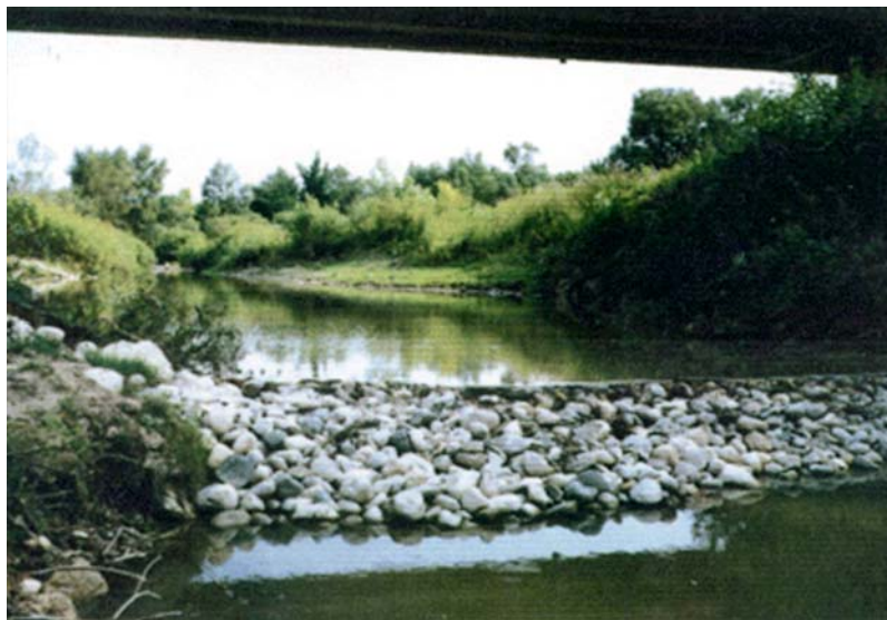
Figure 10. Ouvrage de contrôle à palplanches d'acier avec enrochement, près d'Ottawa (Ontario)
