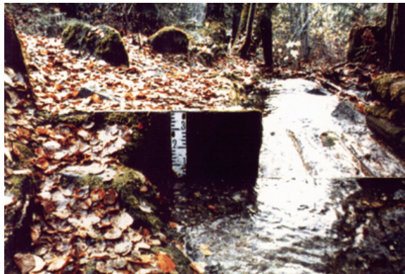
Figure 1. Échelle limnimétrique verticale fixée sur un mur en aile
