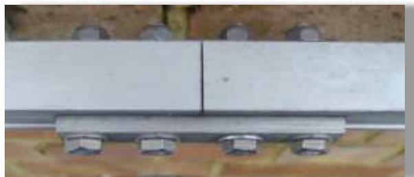
3- Écrou rectangulaire : relie le rail à la platine de fixation
