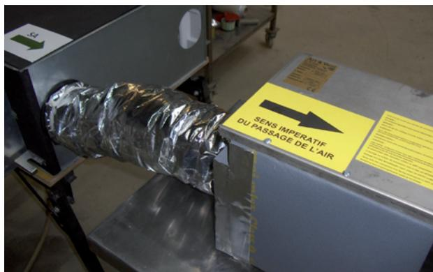
Il faut brancher la gaine sur la sortie d'air neuf (SA) de la centrale sur l'entrée du réchauffeur en respectant 1 m de distance maximum.
