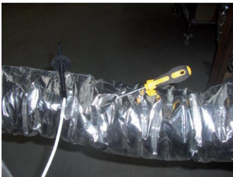
Brancher une sonde de température uniquement dans le cas d'une centrale VMC ADFX. La sonde de température doit être placée à 1 m maximum en sortie du réchauffeur dans la gaine.
