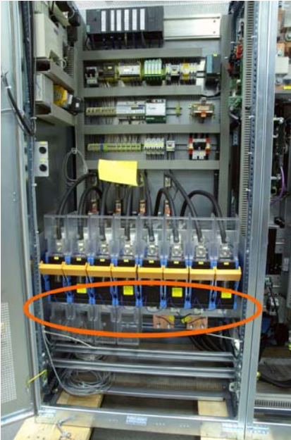
Figure 4-15 Connexion du câble de l'alimentation CC
