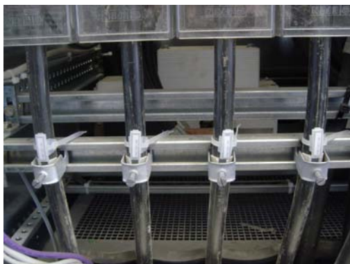
Figure 4-12 Décharge de traction pour câble
