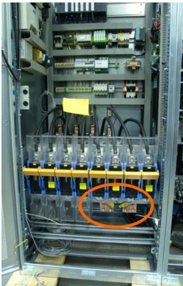
Figure 4-5 Position Raccordement par câble onduleur – circuit intermédiaire CC
