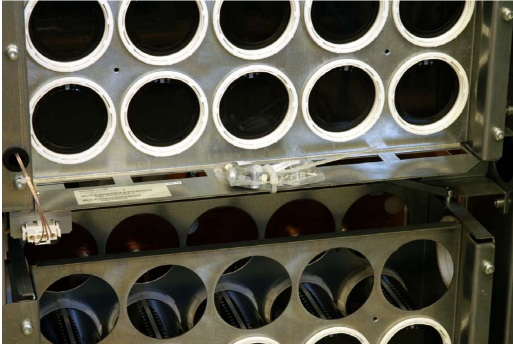
Figure 4-1 Kit de montage pour la connexion à l'armoire
