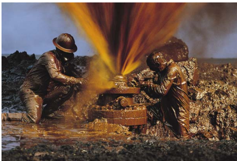
Capsulage d'un puits de pétrole, Koweït © S. Compoin / PNUÉ / Still Pictures
