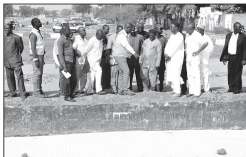
La délégation ministérielle sur un chantier de la voirie
