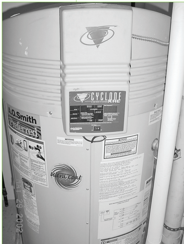
Ce chauffe-eau au gaz a un rendement de 94 p. 100.
