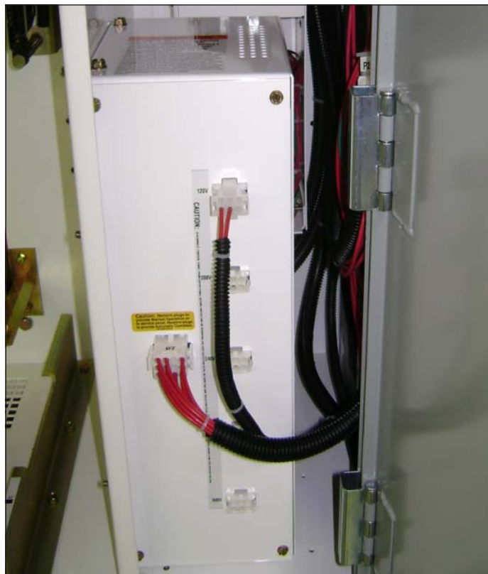
Figure 22. Réglage de sélection de tension (la tension 120 V c.a. est sélectionnée dans l'exemple).
