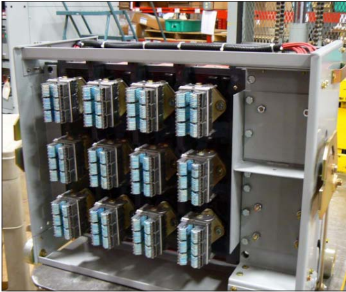
Figure 7. Connexions principales sur le dispositif de commutation, configuration quadripolaire représentée.
