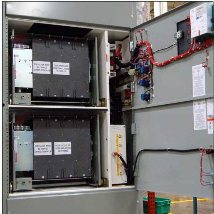
Figure 42. Les quatre roues sont entièrement insérées et le dispositif de levage est retiré.
