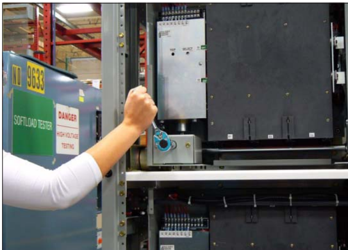
Figure 43. Mouvement de cliquet dans le sens des aiguilles d'une montre.
