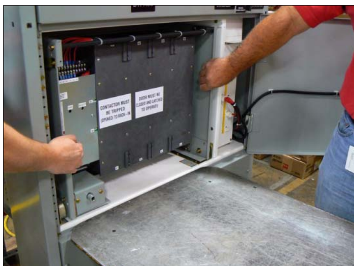
Figure 32. Retrait du mécanisme de levage.
