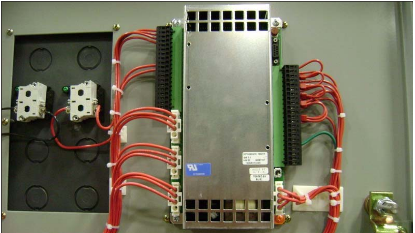
Figure 21B. Contacteur de dérivation ATS (Vue arrière du contrôleur ATC-800).
