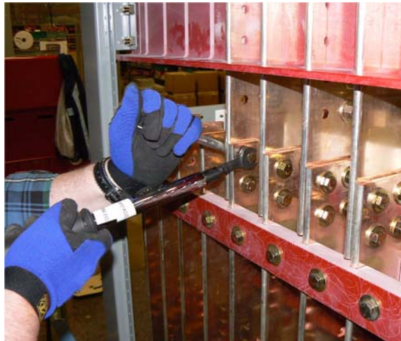
E. Serrez tout le raccord cuivre à cuivre à 400 po-lb.
