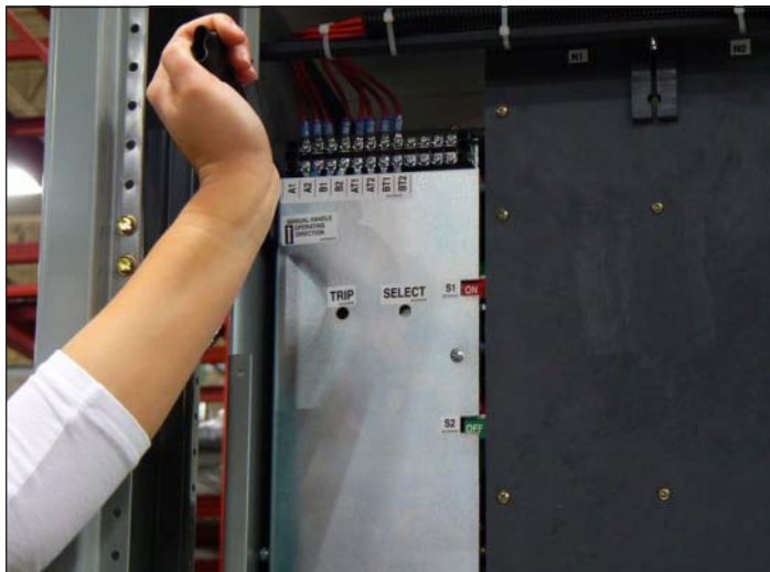
Figure 28. Poignée de fonctionnement manuel de l'ATS en cours d'utilisation.
