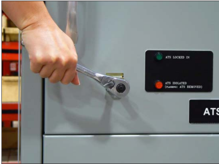
Figure 33. Passage du contacteur dans ses diverses positions en tournant le cliquet dans le sens des aiguilles d'une montre.
