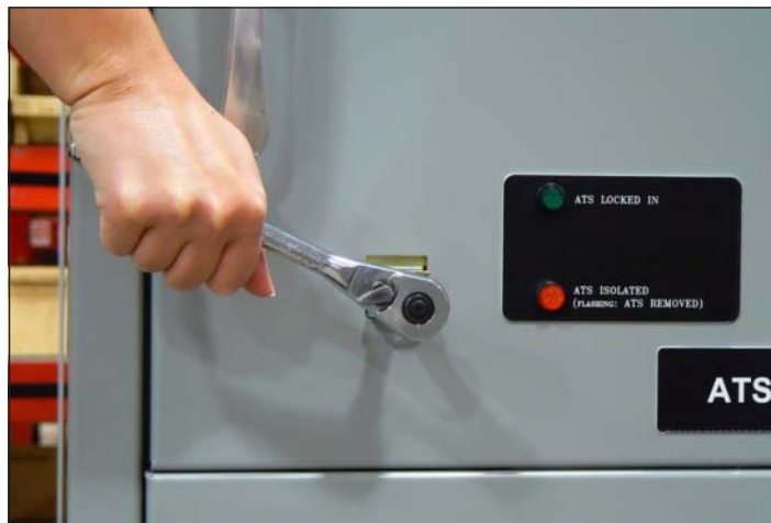
Figure 12. Mécanisme de débrogage.
