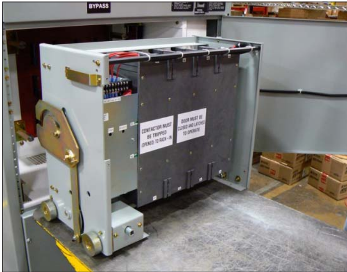
Figure 9. Panneau d'alimentation avant (Contacteur à 4 pôles).
