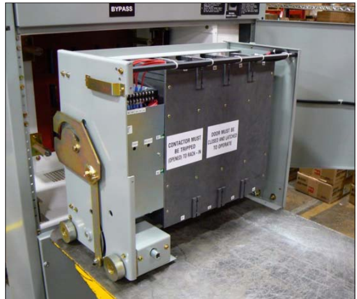
Figure 30. Contacteur ATS sorti du commutateur de transfert.
