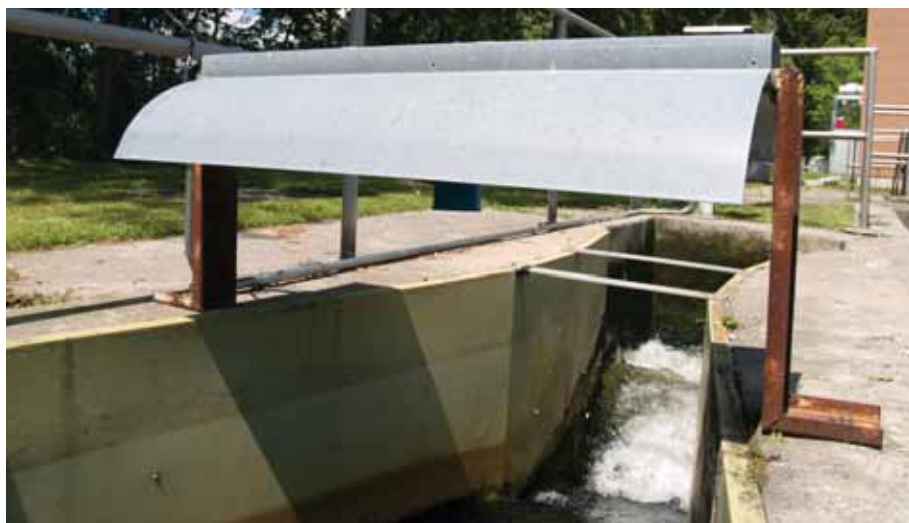
Fig. 2 Des dispositifs pare-soleil évitent que des fluctuations de la température ambiante n'influent sur les résultats de mesure du niveau.
