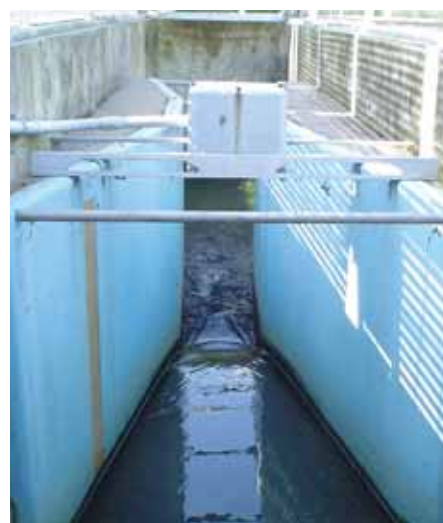
Fig. 3 Plusieurs options sont possibles pour l'installation de transducteurs au-dessus de déversoirs et canaux de jaugeage. Une mesure précise du niveau de ces canaux ouverts contribue à éviter les débordements.
