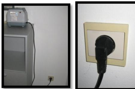
Figure 7-11: Raccordement électrique en bâtiment pour les Oxyfix 4,5 et 6EH
