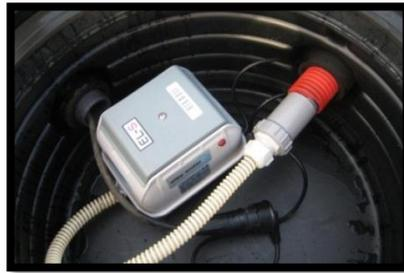
Figure 7-12: Raccordement électrique en local technique pour les Oxyfix 4,5 et 6EH
