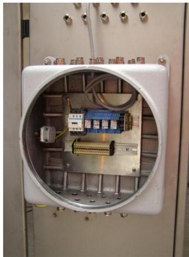
Montage du contrôleur de surpression, du coffret de sectionnement, des accessoires Ex-d externes (klaxon, éclairage, interrupteur principal ...)
