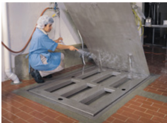
Installation de la balance à ras du sol pour un chargement rapide des marchandises et un accès aisé pour le nettoyage
