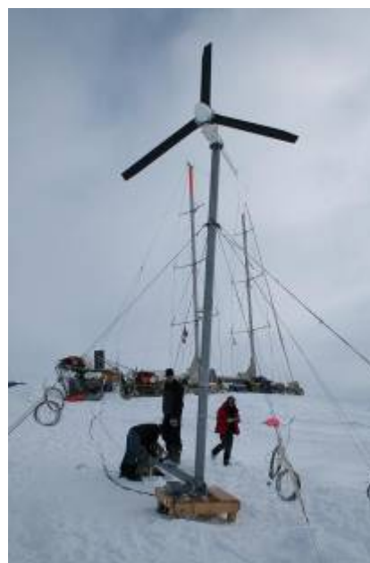
Photographie 18 : Eolienne de 3 kW. (© Tara Expéditions - Marion Lauters).
