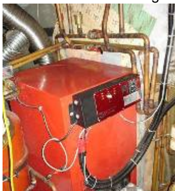
Photographie 7 : Chaudière 40 KW du Tara. (© Tara Expéditions - Marion Lauters).
