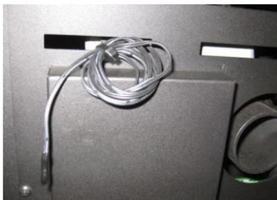
Figure 10 – Sonde de température ambiante
