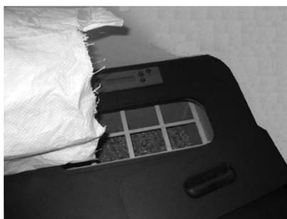
Figure 17 – Réapprovisionnement du réservoir à granulés
