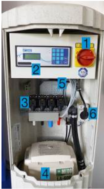
Figure 5: Vue intérieure Pilier-A
