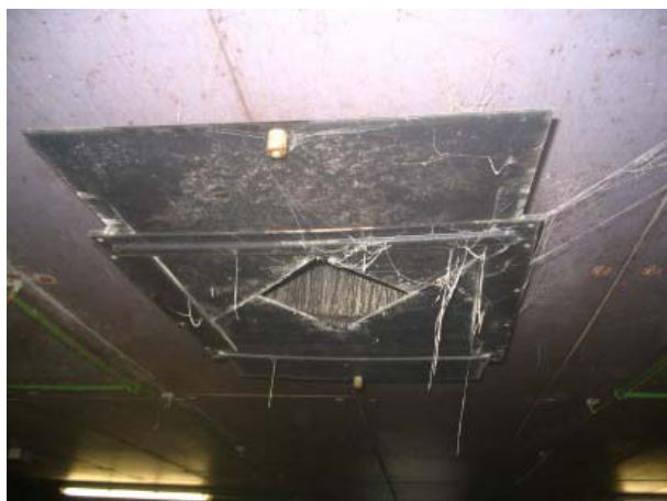
Photos 4 & 5 : Conduit vertical d'extraction dans une salle de post-sevrage et ventilateur correspondant.
