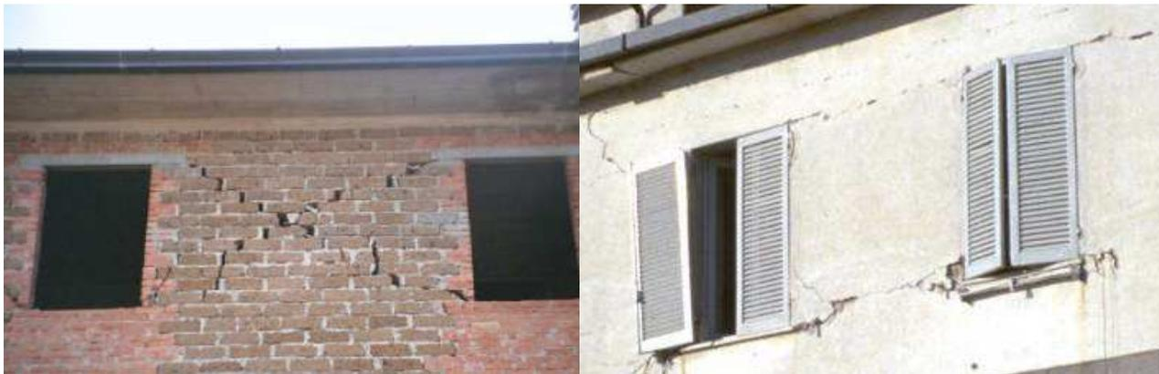
Figure 5.1. Ruptures caractéristiques observées (doc. Tremuri)
