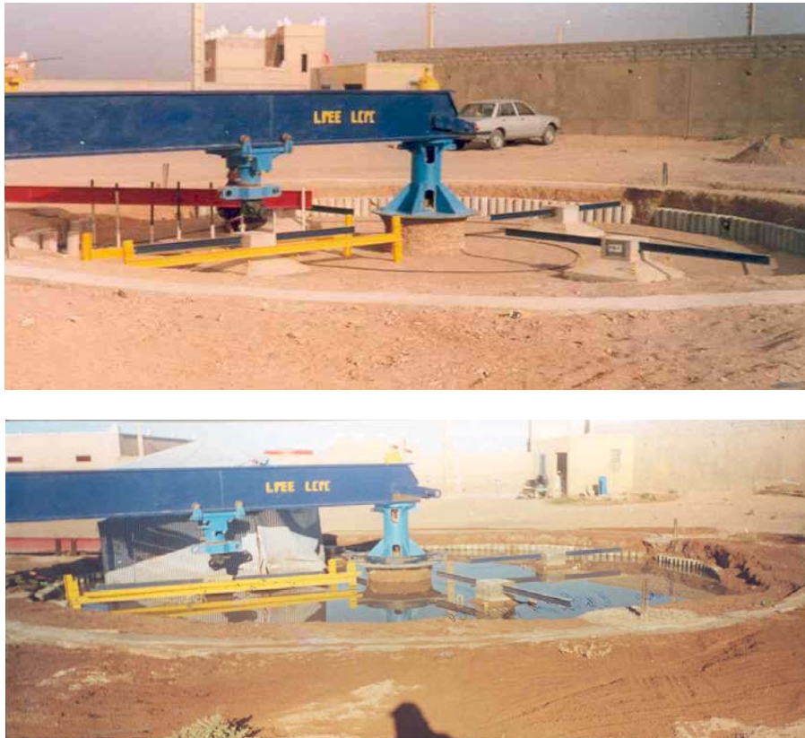
Figure 27. Vue d'ensemble de la station d'essais lors de la construction et lors de la submersion sur le site expérimental du LPEE à Ouarzazate
