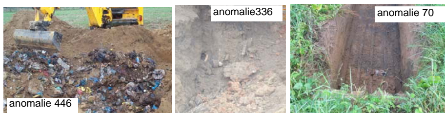
Figure 10. Exemple de puits de marnières révélés lors de la campagne de décapage à la pelle. Sur l’anomalie 446, à 0,7 m de profondeur, la pelle a rencontré un très grand nombre de sacs contenant des déchets ménagers laissant envisager la présence d’un effondrement lié à une marnière. Sur l’anomalie 336, apparaissent des éléments de remplissage du puits d’une marnière sur une zone de 1,5 m à 2 m de diamètre (présence d’une souche d’arbre probablement là pour bloquer l’entrée du puits). Sur l’anomalie 70, à 1 m de profondeur, des morceaux de verre, de bois et de plastique ont été découverts par la pelle, dans une zone circulaire de 1,8 m à 2 m de diamètre, sur plus de 3 m de profondeur. Compte tenu du diamètre de la zone concernée, il devrait s’agir d’un puits de marnière.
