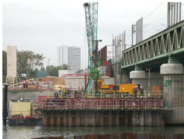
Figure 39. Vue des travaux d'installation des micropieux à partir du batardeau de la pile P2 (octobre 2004). On note la proximité de l'ancien pont de 1864.
