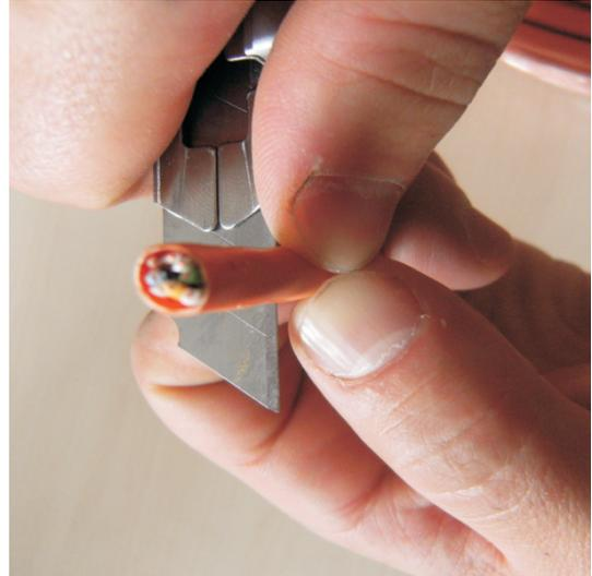
1. Dégainer le câble RJ45 CAT6 sur 40 mm minimum.
