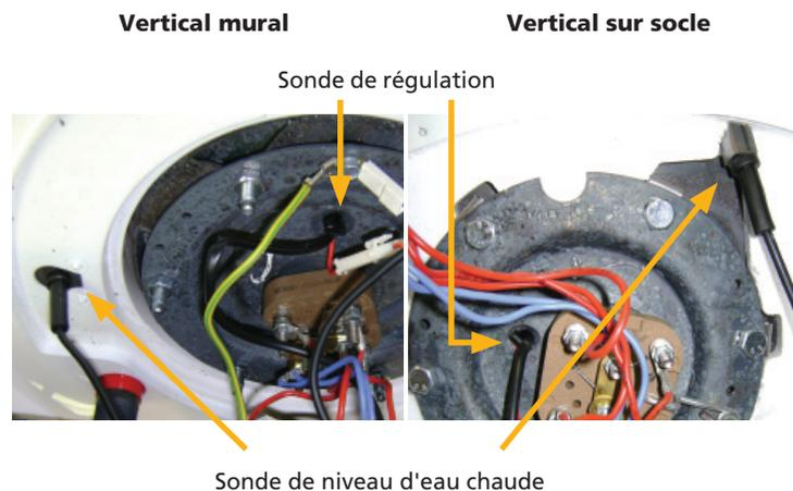
9. Vidanger la cuve et démonter l'ensemble chauffant (corps de chauffe et élément chauffant).
