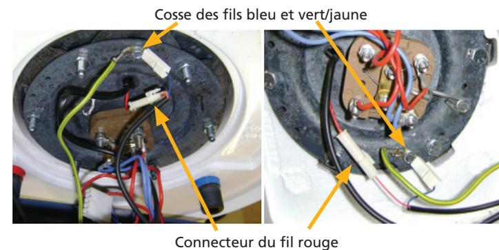
8. Sortir les sondes de régulation et de niveau d'eau chaude de leurs emplacements.
