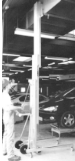
... pour les travaux d'installation
