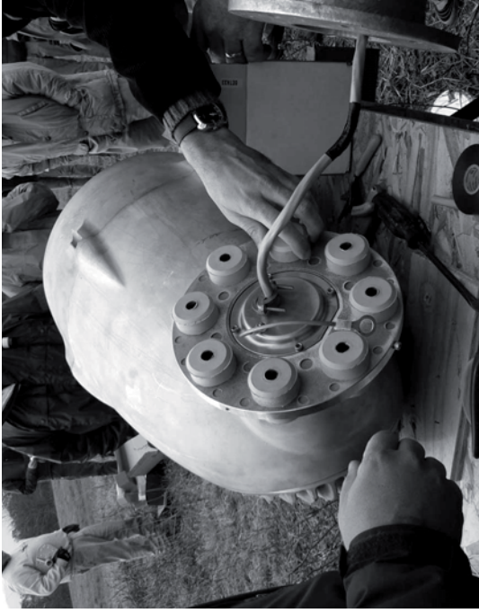
III. 4 Installer les isolateurs de vibration
