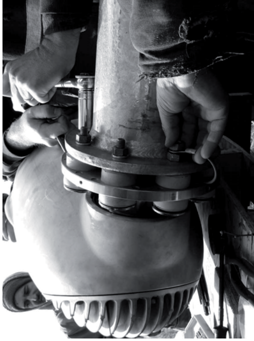
III. 5 Mettre la turbine à la terre sur le mât
