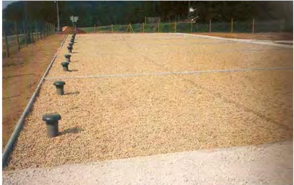
L'effluent prétraité est injecté par des drains d'épandage dans un massif de gravier pour éviter les eaux en surfaces. Les cheminées visibles sont les événements d'aération du réseau de drains de collecte.
