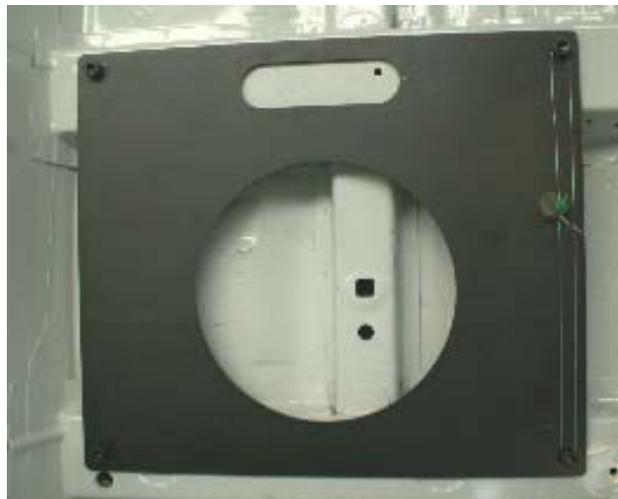
La fixation de ces plaques sur la caisse se fera obligatoirement par deux vis à tête percée réf
