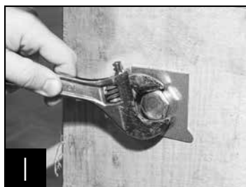
1 Dépose du socle de la base du meuble
