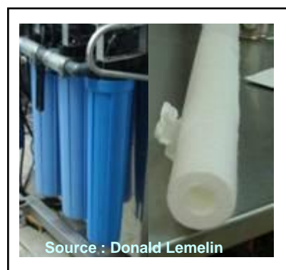
Figure 21 : Caissons et cartouche d'un préfiltre.
