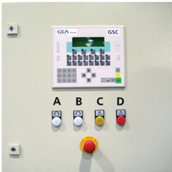
fig. 1: Vue extérieure GSC
