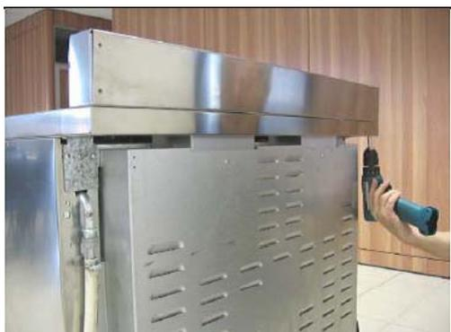
Raccorder la partie arrière et frontale du bord. Vérifier si l'assemblage est bien serré.
