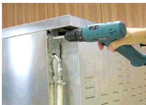
Installer la partie frontale de la protection arrière en serrant les 2 vis centrales du haut et les 2 vis latérales du fond
