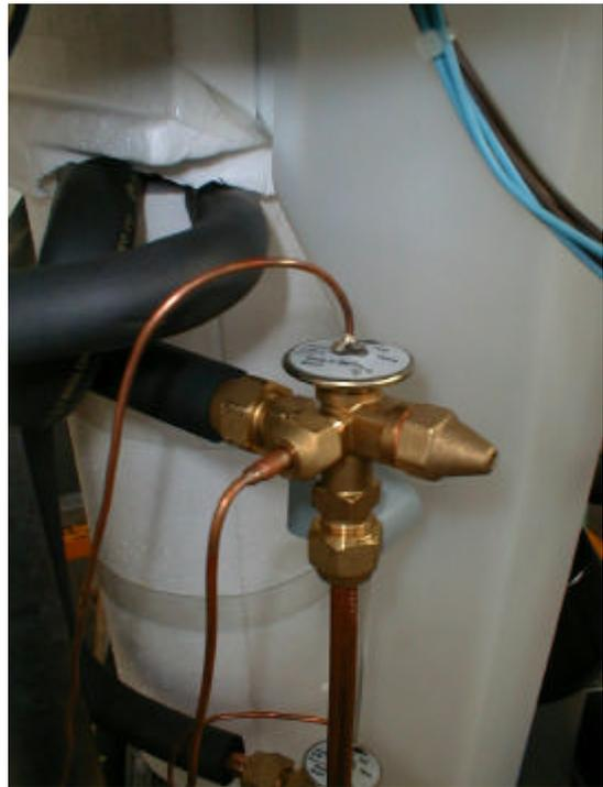
5. Vanne à pression évaporation constante Danfoss KVP 12 sur MF 52 et Danfoss KVP 22 sur MF 62
