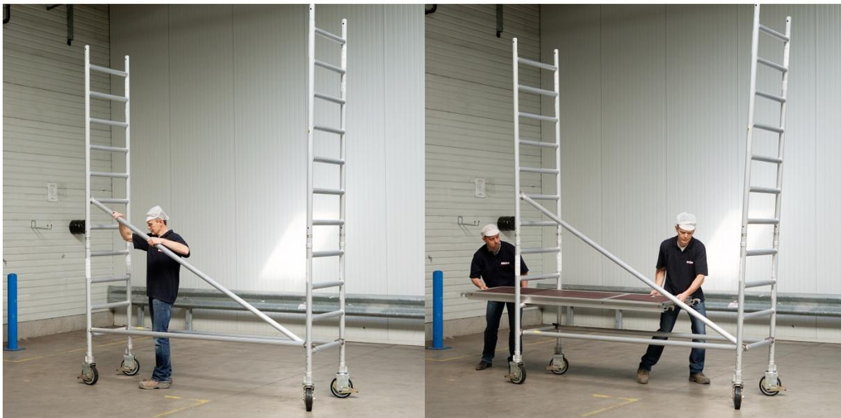
6) Posez un garde-corps RS xxx L-4S sur l'échelon le plus haut. Ouvrez les lisses diagonales intégrées du garde corps et cliquez-les sur le 4<sup>ème</sup> échelons du haut. Vérifiez le bon verrouillage des griffes de fixation des lisses. Faites ça sur les 2 côtés.
