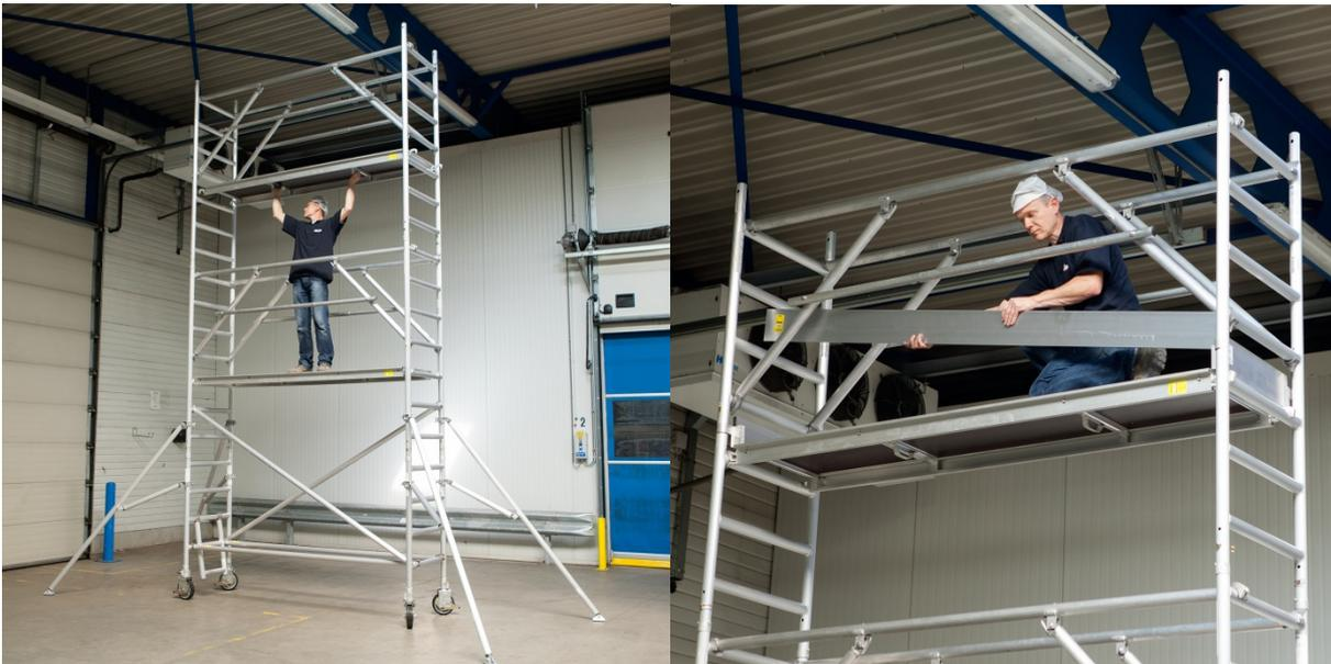
14) Les différents éléments seront passés manuellement d'un plancher à l'autre, ou hissés à l'aide d'une corde, en restant à l'intérieur de la base de sustentation de l'échafaudage. Aucun engin de levage ne peut être fixé à l'échafaudage.
