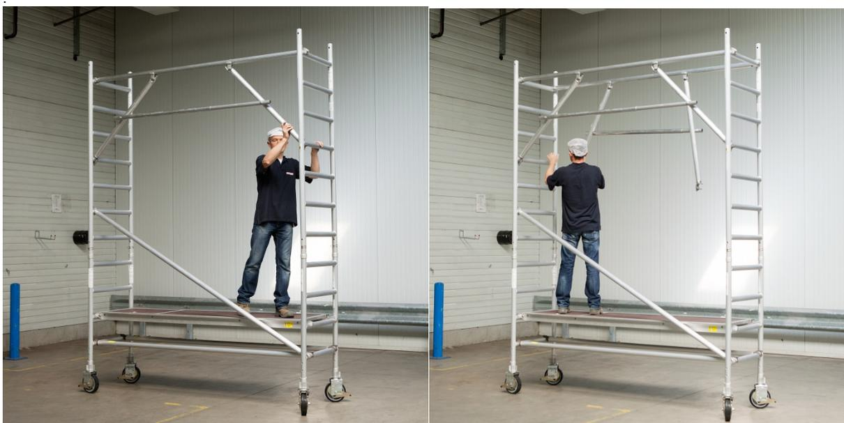
7) Mettez le plancher qui se trouve en situation temporaire sur le 5<sup>ème</sup> échelon au-dessus de la section et verrouillez manuellement le doigt anti-soulèvement de chaque plateforme. Pour un échafaudage du type RS135 les plateformes de chaque niveau doivent être jointives. Veillez à ce qu'au moins une des plateformes de chaque niveau dispose d'une trappe d'accès.
