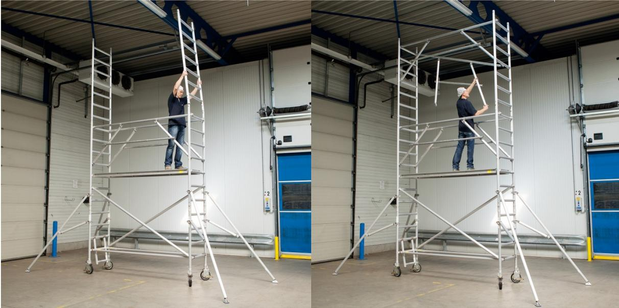
12) Posez ensuite un plancher sur le 5<sup>ème</sup> échelon du haut et verrouillez manuellement le doigt anti-soulèvement de chaque plateforme. Dans un échafaudage large (RS135) les plateformes de chaque niveau doivent être jointives. Veillez à ce qu'au moins une des plateformes de chaque niveau dispose d'une trappe d'accès.
