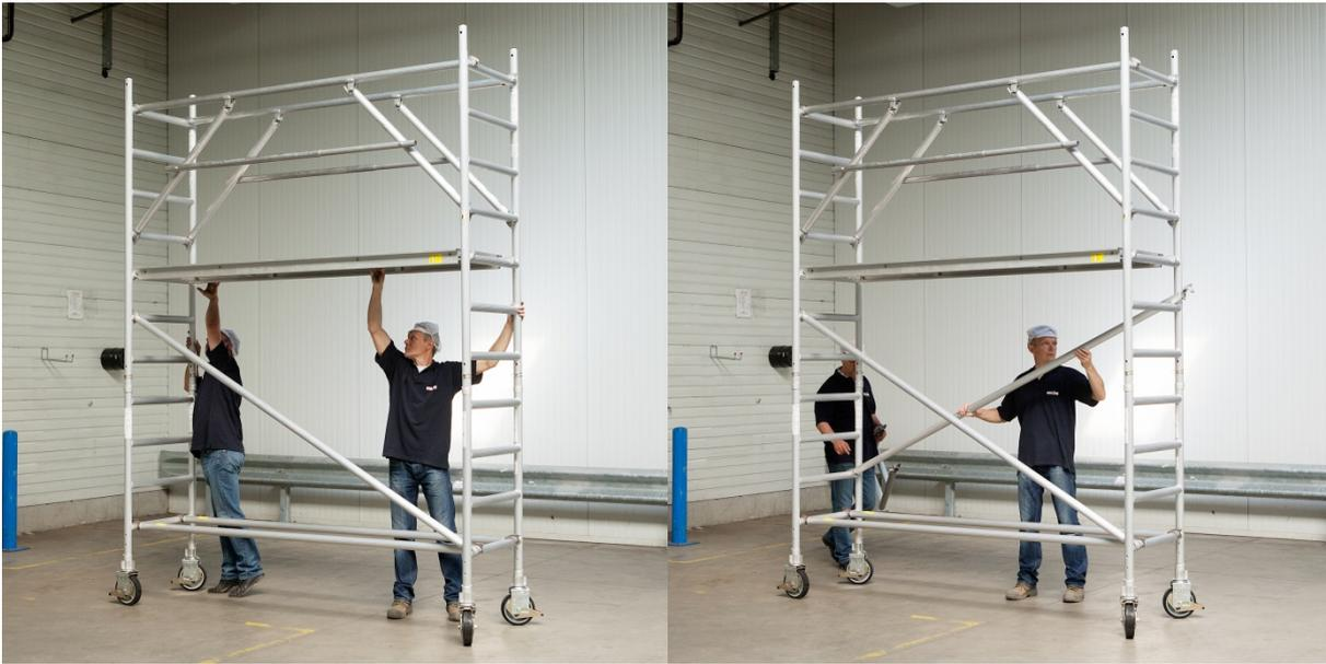
Placez ensuite la section de base parallèle au sol.. Effectuez ce positionnement en dévissant les tiges des roues, en agissant sur l'écrou de réglage. La pente maximale admise est de 1%. Utilisez un niveau à bulle pour l'ajustement de l'échafaudage. Placez le niveau sur un échelon, puis sur la longueur d'une plateforme. Les échafaudages roulants adossés à un mur peuvent être légèrement inclinés vers celui-ci.
