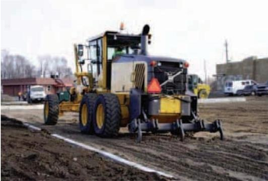
Il est également possible d'incorporer de la chaux à l'aide d'un **scarificateur frontal**. Pour supporter des **équipements supplémentaires**, l'engin doit avoir une plus grande capacité (**moteur plus puissant**). Les équipements montés à l'avant comme à l'arrière sont à commande **hydraulique**. Quand ils ne sont pas utilisés, ils sont relevés dans la position la plus haute. Il ne faut donc **pas les démonter** quand ils ne sont pas utilisés.
