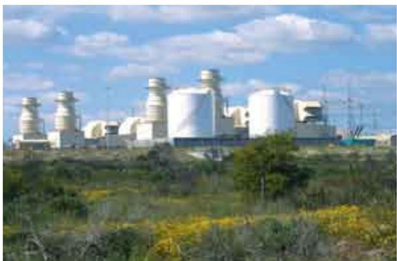
KAEFER Thermal a achevé avec brio la première étape du projet « Open Cycle Gas Turbine » (OCGT) de CAMFIL-FARR en isolant un système d'échappement de turbines à gaz sur sept unités, isolations requises afin de répondre au besoin énergétique de deux centrales en périodes de pointe. 1050 mégawatts supplémentaires ont ainsi pu être fournis. Il s'agissait du plus grand projet OCGT au monde.
