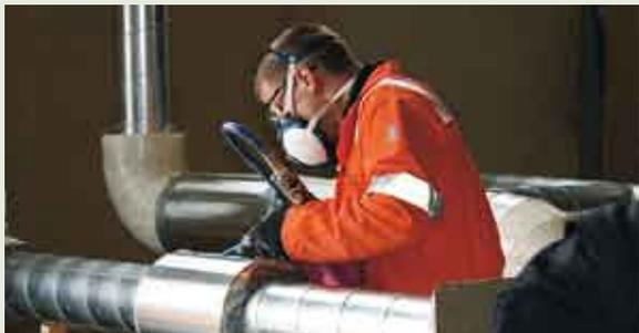
*L'isolation sous-marine est injectée dans la cavité entre la canalisation et la manchette.*
