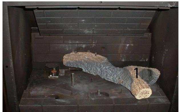
4. Glisser doucement la plus longue "demi-bûche" (2) dans le montant D. S'assurer de placer l'arrière de la bûche sur le devant de l'ensemble de la veilleuse et contre le côté gauche de la boîte de combustion tel qu'illustré ci-après.
