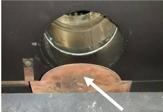
Figure 32 - Plaque de Restriction Totalement Ouverte (déflecteur enlevé pour la clarté)
