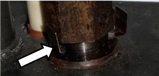
**Figure 26 – Dévisser la Tour et Glisser la Barrière de la Veilleuse Derrière la Tour de la Veilleuse (en position GP)**
