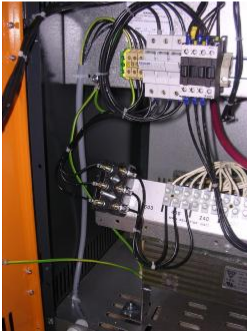
Cette image montre comment se réalise la connection du réseau dans l'armoire LP
