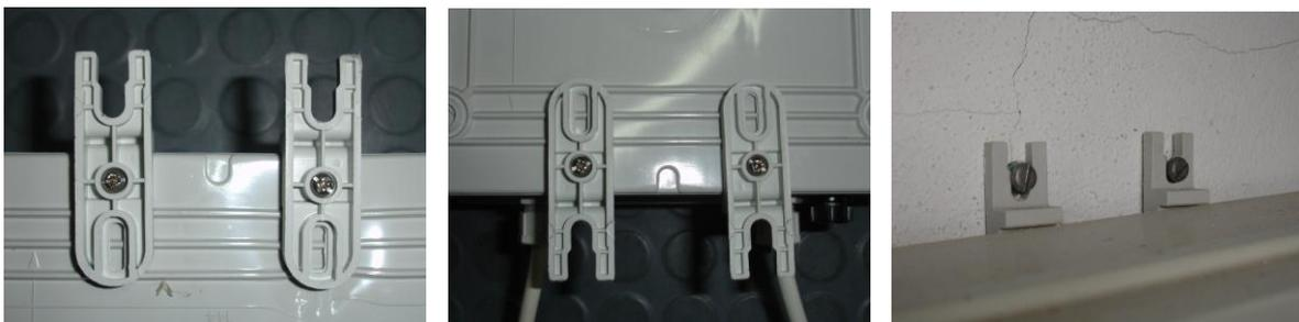
Fixations du Coffret Electrique de l’Hidrion au mur.
