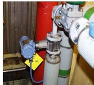
Installation avec bus de terrain Foundation
