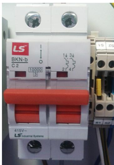
**Figure 11 :** Magnétothermique bipolaire du circuit d'alimentation auxiliaire
