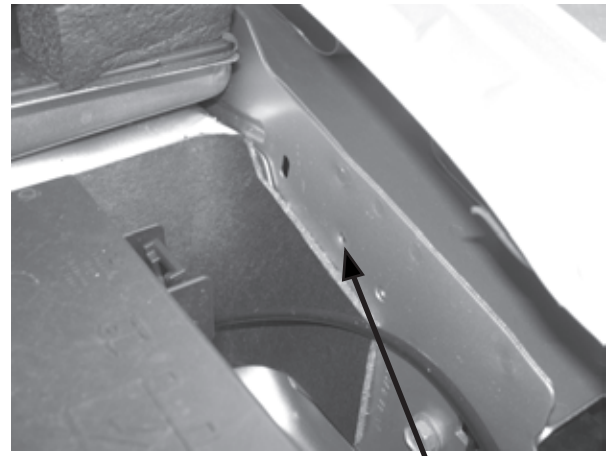
localización del montaje
