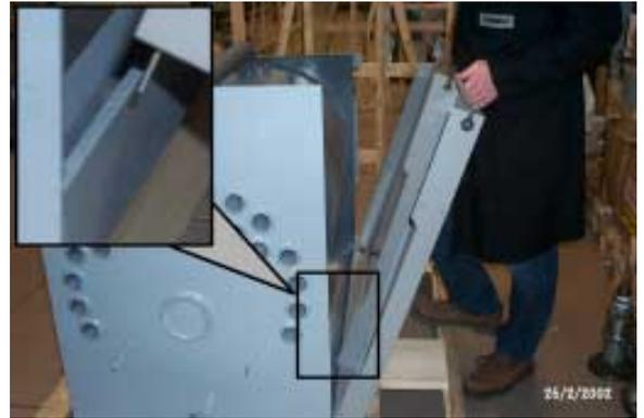
F positionner les montants sur le corps de la chaudière.
