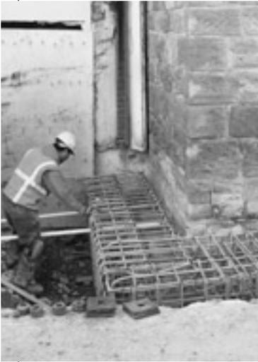
**Il a fallu renforcer les fondations pour les mettre aux normes sismiques.**
