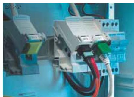
L'adaptateur DRM a été conçu spécifiquement pour garantir une intégration commode de la technologie numérique aux rails DIN normalisés de 35 mm (DIN EN 50 022). Il est à usage universel, permet de gagner de la place grâce à son format idéal et son montage est exceptionnellement simple. Le résultat est un support efficace et convaincant pour l'intégration horizontale et verticale des composants du système.
