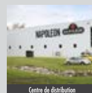
Centre de distribution
