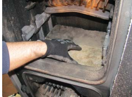
Fig. 20 Rasillas de cemento
