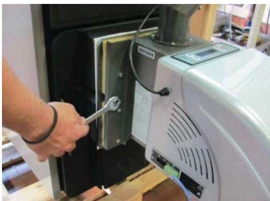
Fig. 25 Montaje quemador
