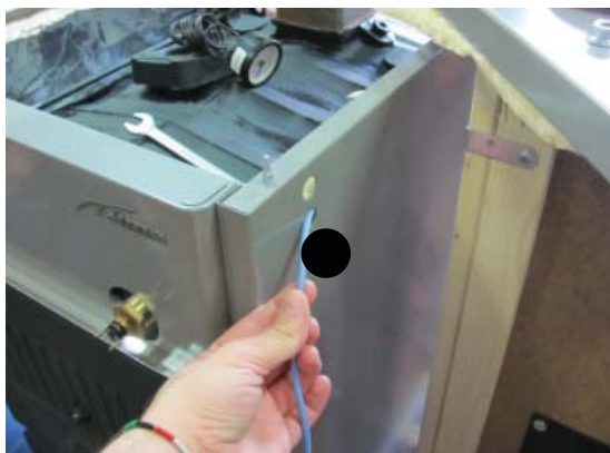
Fig. 35 Sonda impulsión
