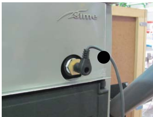
Fig. 34 Conector termostato de seguridad
