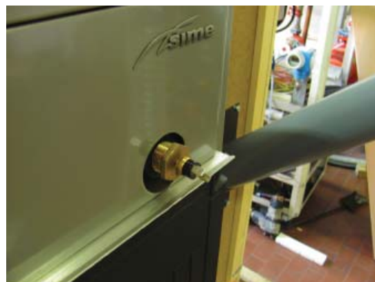
Fig. 28 Termostato de seguridad
