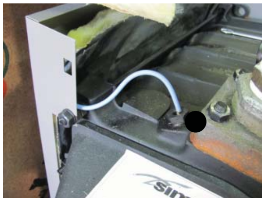
Fig. 36 Sonda impulsión
