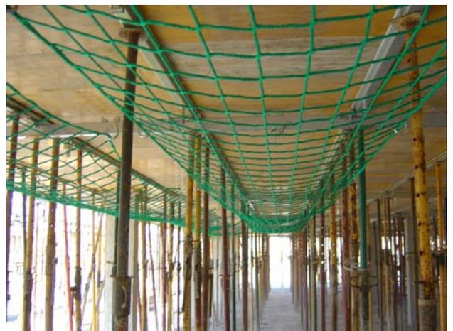
**Esquema de montaje de las redes de seguridad bajo forjado**
