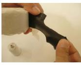
2.-Corte un pedazo suficiente de cinta masilla para realizar el relleno.
