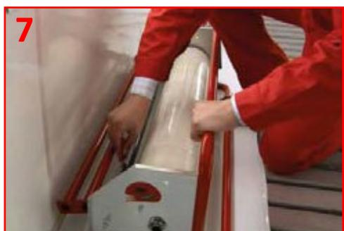
*Porada: jeśli na ścianie jest zbyt wiele „przeszkód”, jak okna, wywietrzniki itp., wygodniejsze może okazać się nałożenie folii ręcznie za pomocą podajnika Colad Film4Booth, bez używania aplikatora. Folię można łatwo wygładzić szczotką.*
