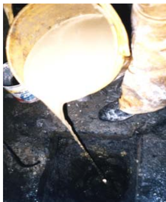
Figura. 31. Aplicación de Hidrosolta en la base del pozo.
