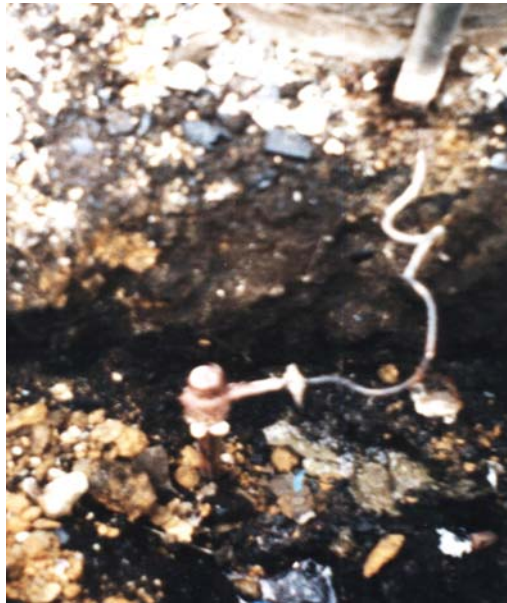
Figura 35. Conexión exotérmica del electrodo
