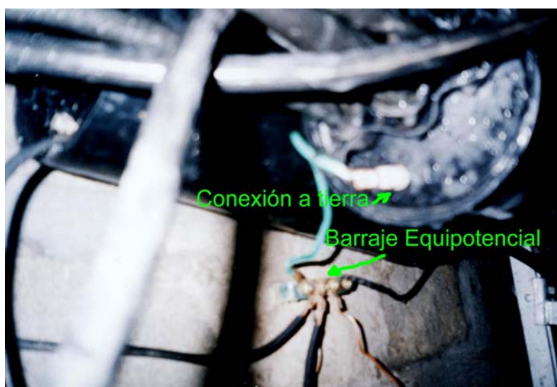
Figura 7. Conexión equipotencial.
