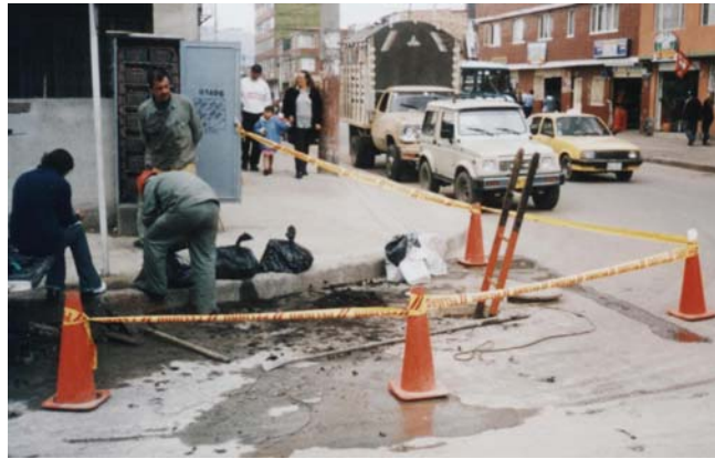
Figura. 26. Delimitación del área de trabajo y seguridad.
