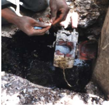
Figura. 33. Preparación de la conexión exotérmica.
