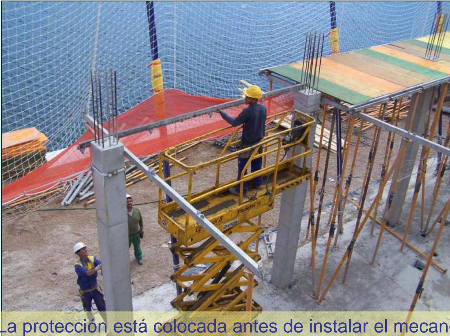
La protección está colocada antes de instalar el mecano
