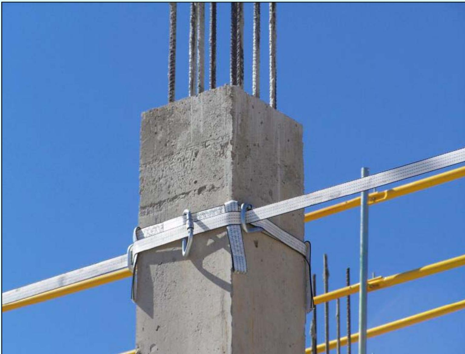
Sistema V con elevación del punto de anclaje – Dispositivos en espera
