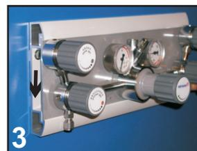
4.4 La placa de instrumentos hay que ajustar con el tornillo hexagonal interior (imagen. 4).
